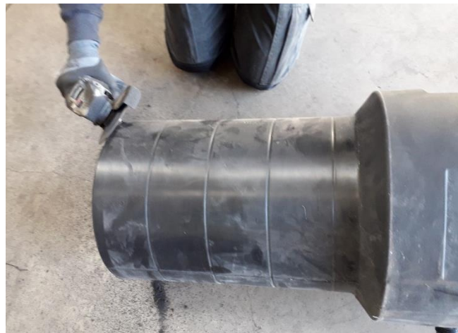
Fig.14 – chanfreinage de la rehausse
