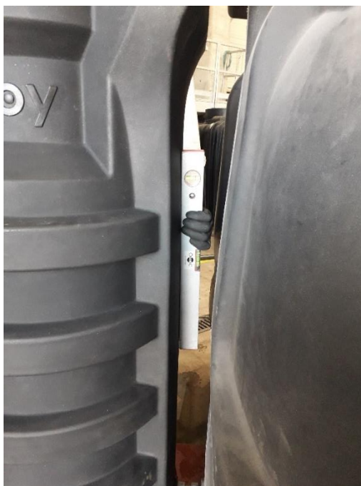
Fig.9 – vérification du niveau après fixation à un filtre compact x-perco® R-90 monobloc
