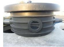
2. Après avoir percé les rehausses, enfoncez les joints d'étanchéité dans les réservations.
