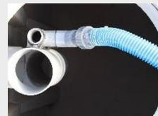
Branchez le surpresseur et vérifiez le bon fonctionnement de la recirculation dans le décanteur primaire.
