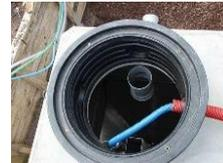
Placez le tuyau de recirculation dans sa gaine de protection et connectez-le aux dispositifs prévus à cet effet dans le décanteur primaire et le clarificateur.
