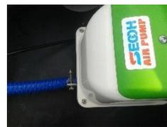
Fig-12 : raccordement côté surpresseur
