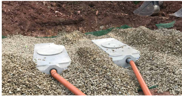
Fig-21 : remblai au gravier jusqu'à l'épaule des infiltror® C-90
