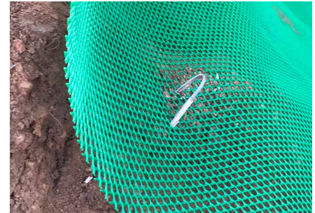
Fig-18 : exemple de crochet de fixation
