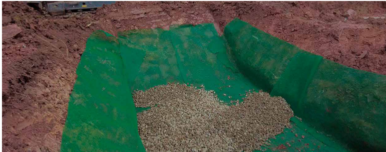
Fig-17 : fouille avec géogrille installée
