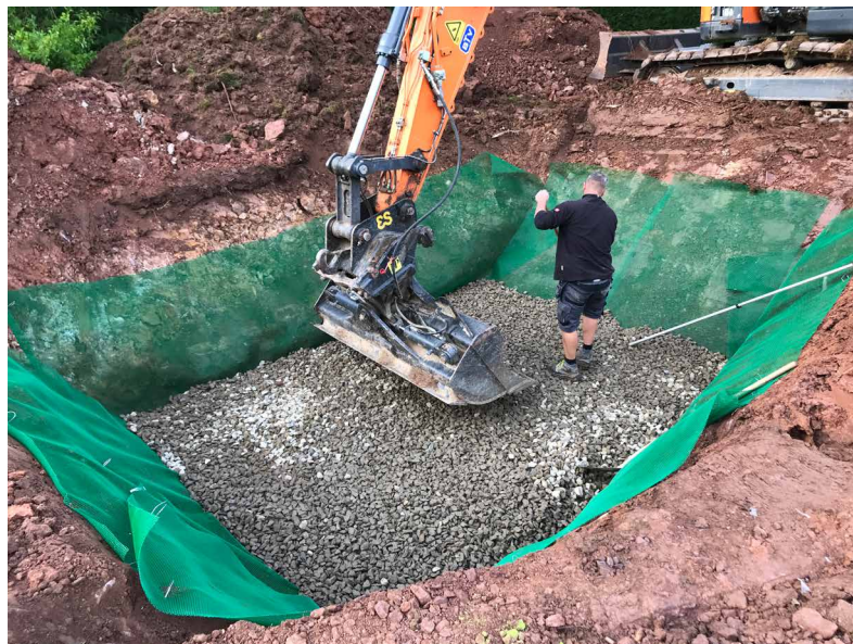
Fig-19 : réalisation du lit de pose
