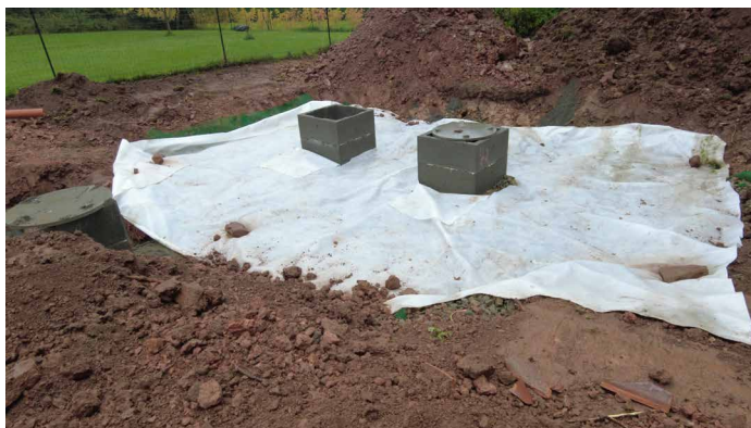
Fig-25 : pose du géotextile sur 2 infiltror® C-90 avec rehausse béton
