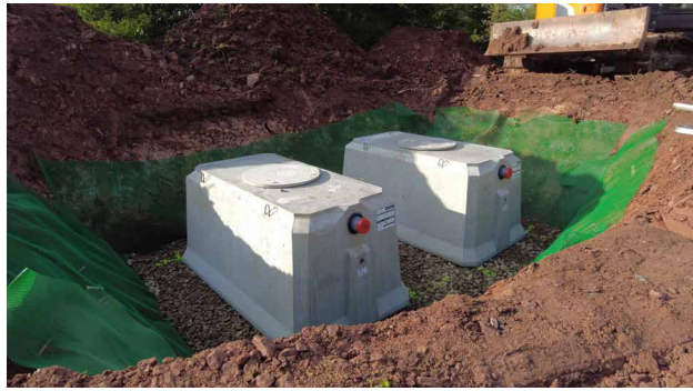
Fig-20 : pose de 2 infiltror® C-90
