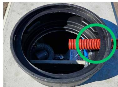
4. Placez le tuyau de recirculation dans sa gaine de protection et connectez-le à la pompe de recirculation par le biais du raccord rapide prévu à cet effet. Re-placez alors la pompe dans le fond du clarificateur.
