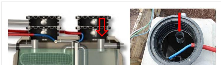
Fig-6 : Té d'échantillonnage dans une installation oxyfix® avec réacteur-clarificateur
